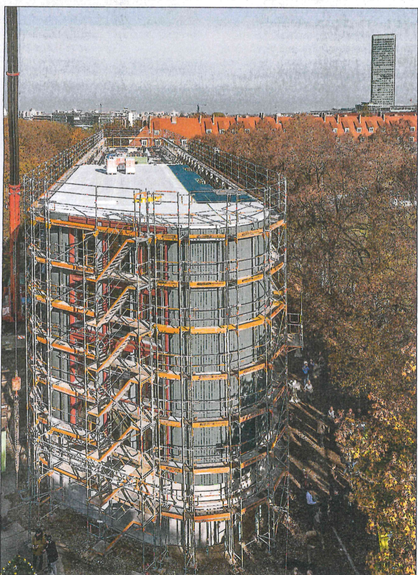
Dantebad in München, errichtet von der B&O-Gruppe als Generalunternehmer und Huber & Sohn als Holzbaubetrieb. Die Montage auf der Baustelle, bei der insgesamt 4100 m 2 Decken- und Flachdachelemente sowie 7500 m 2 Innen- und Außenwandelemente montiert wurden, dauerte insgesamt nur acht Wochen.
