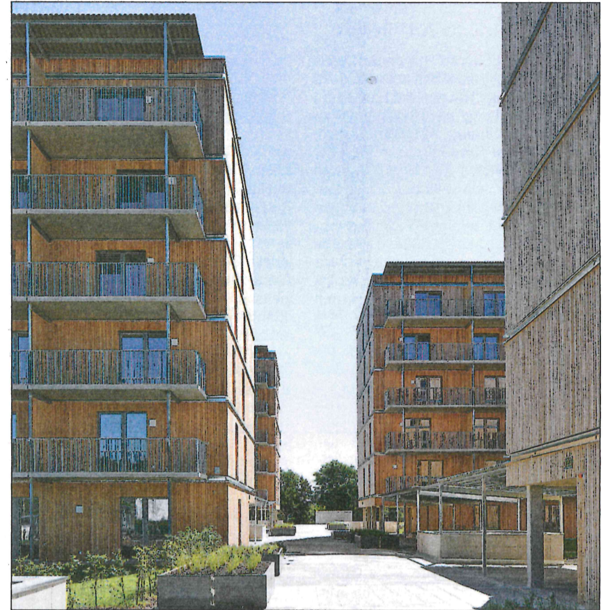
Die geschossweisen, hinterlüfteten geschlossenen Fassaden (aus vertikalen Lärchenholzbrettern) und verblechte horizontale Fugen sorgen bei der Wohnsiedlung „Hummelkaserne“ in Graz für den erforderlichen Brandschutz der Gebäudehülle. Foto: SPS Architekten / P. Ott; Fotos Referenten: Susanne Jacob-Freitag
