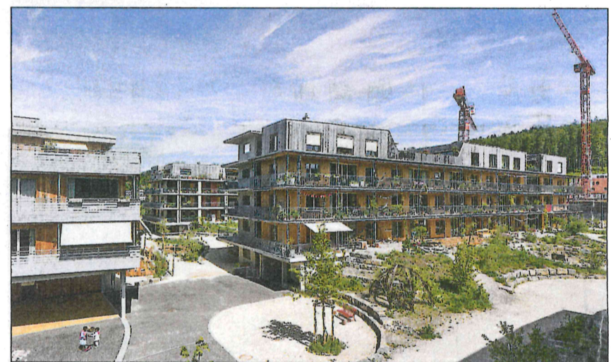
Die im Passivhaus-Standard errichtete Wohnbausiedlung Oberfeld in Ostermündingen bei Bern erfüllt vor allem den Aspekt der „ökologischen Verantwortung“ in der Reihe der sechs Nachhaltigkeitsthemen der Halle 58 Architekten. Die Siedlung umfasst 100 Wohnungen, 50 Eigentums- und 50 Mietwohnungen. Laubengänge charakterisieren die Häuser. Foto: Halle 58 Architekten/Christine Blaser
