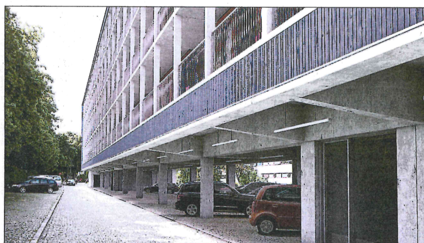
Blick auf die Stellplätze unter den vier Holzbaugeschossen der 100 m langen und 11 m breiten Wohnüberbauung am Dantebad. Der Holzbau setzt auf einem Betontisch mit Stützen und Trägern aus Stahlbeton auf. Fotos (2): Florian Nagler Architekten
