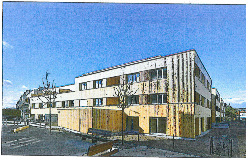
Das geförderte Wiener Wohnbauprojekt Paulasgasse umfasst 80 Wohneinheiten auf vier Baukörper verteilt, die jeweils drei Vollgeschosse und ein zurückgesetztes Dachgeschoss haben – alles in Holzbauweise. Foto: J. Kaufmann Architekten
