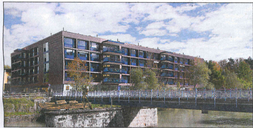
Seniorenwohnhaus in Hallein: Außen ein klarer Korpus, der durch die Balkone eine Gliederung erhält. Die vier mit Kupfer bekleideten Obergeschosse scheinen fast über dem Sockelgeschoss zu schweben. Foto: SPS Architekten/D. Tollerian
